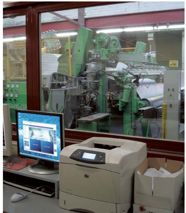
75 Sala di comando di una macchina per carta. All'interno della sala di comando il rumore di fondo è di 65 dB(A), mentre all'esterno il rumore può raggiungere i 90 dB(A).
