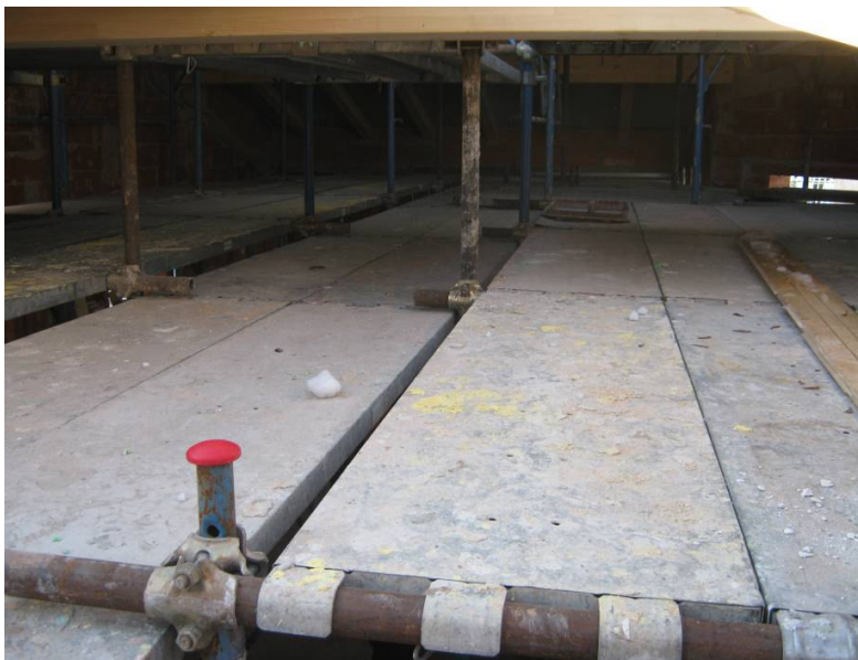
FOTO 3. Soluzione di sicurezza con installazione di sottoponte di sicurezza e con installazione di funghi protettivi quali “copri ferro” nella parte terminale del montante del ponteggio.
