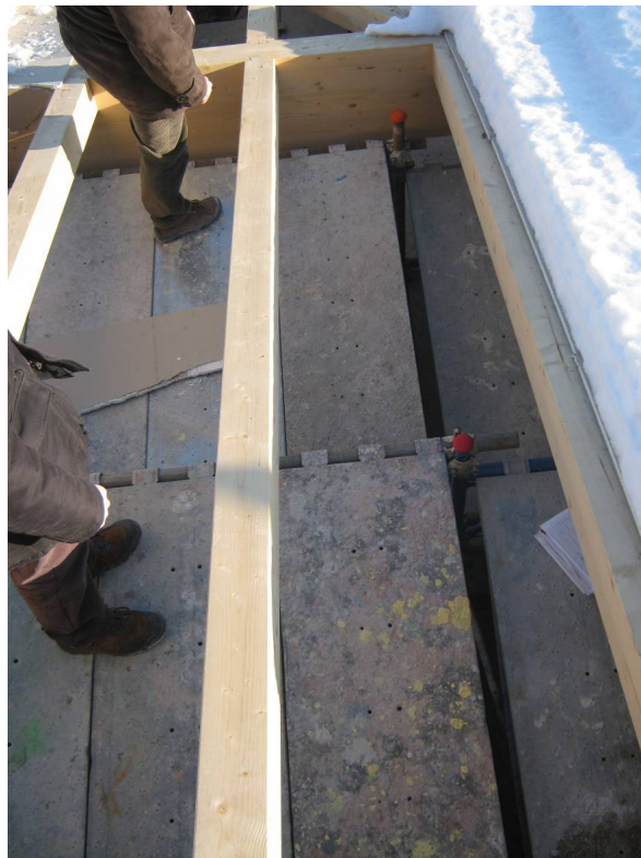
FOTO 1. Soluzione di sicurezza con installazione di sottoponte di sicurezza e con installazione di funghi protettivi quali “copri ferro” nella parte terminale del montante del ponteggio.
