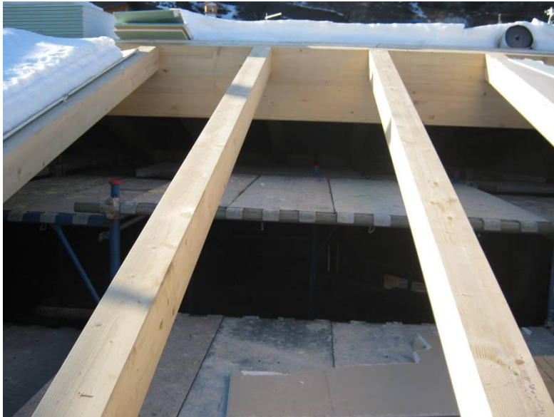
FOTO 2. Soluzione di sicurezza con installazione di sottoponte di sicurezza e con installazione di funghi protettivi quali “copri ferro” nella parte terminale del montante del ponteggio.
